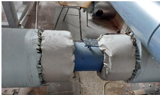
Bild B.5.4 – (keramisches) Isolierstück eines Fernwärmeanschlusses
