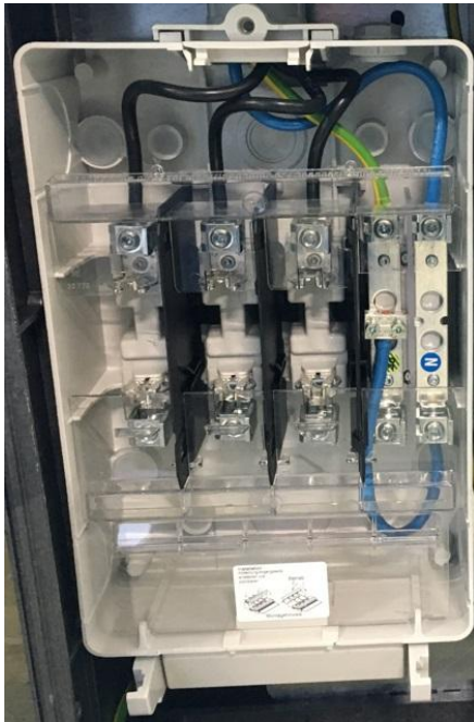
Dreiphasiger Anschluss (ohne Deckel), vorverkabelt für Netzform TN-C und Anlagenanschlutung TN-S
