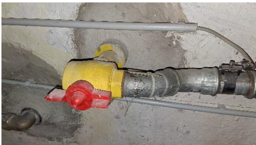
Bild B.2.14 – Gasanschluss
