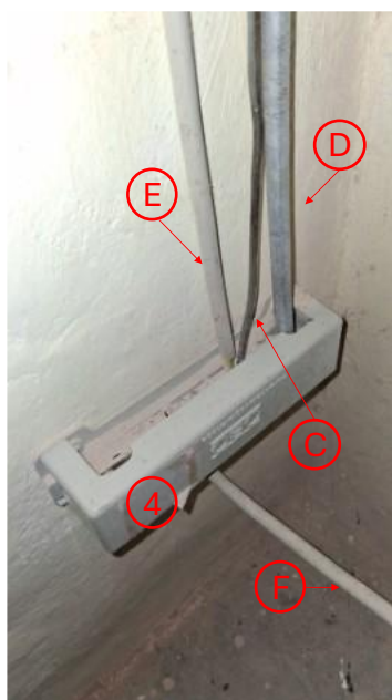
Bild B.3.1 – HES in Altbau-Keller installiert
