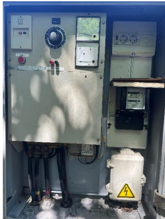
Bild B.4.2 – Anlage im Außenbereich, die die Gleichspannung erzeugt
