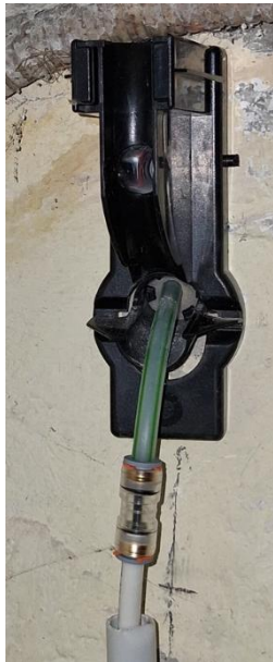
Mikrorohr für Einblastechnik (mit Codierung „grün I“, Gasblocker (durchsichtig) und [falsch genutztem] Knickschutz (schwarz))
