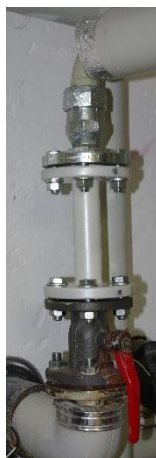
Bild B.5.5 – (keramisches) Isolierstück eines Fernwärmeanschlusses
