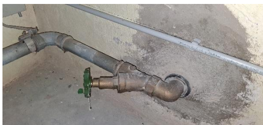
Bild B.2.15 – Wasseranschluss
