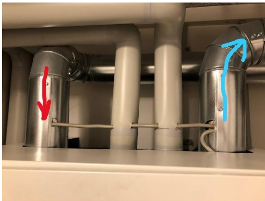
Bild B.2.13 – Zuführung einer FW-Übergabestation
