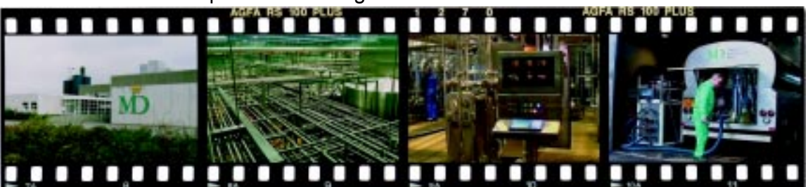
Automation einer Käseproduktionsanlage
